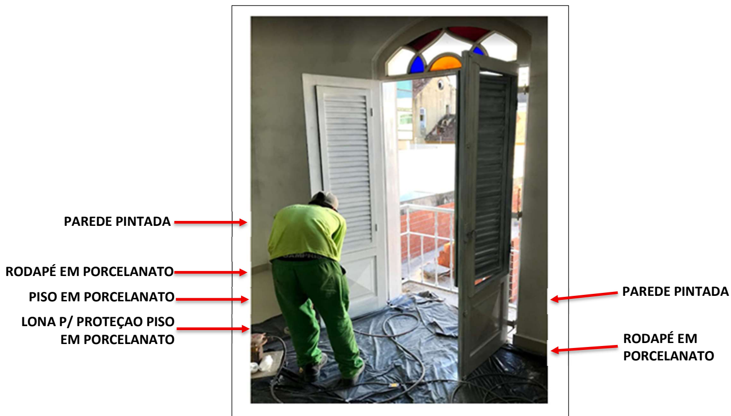
Instalação do porcelanato no piso e nos rodapés.
